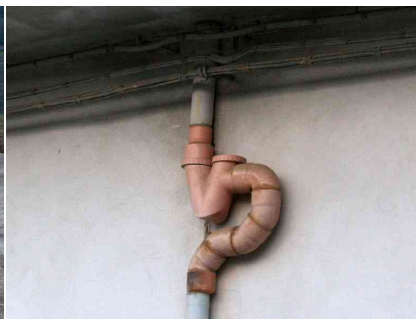
排水管のトラップが露出している。トラップがあったときはメンテナンスが楽かもしれないが。
