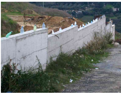
コンクリート擁壁にペットボトルが埋め込まれているのは、フェンスなどの支柱を建てるためらしい。
