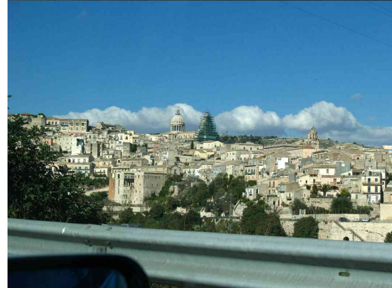
上:モディカ駅近くの高架橋(P.86)から街を見下ろす。 中:モディカを離れて数分、115号線が右へ分岐する。 下:ラグーサ・イブラ。中央部に修復工事中的の大聖堂。
