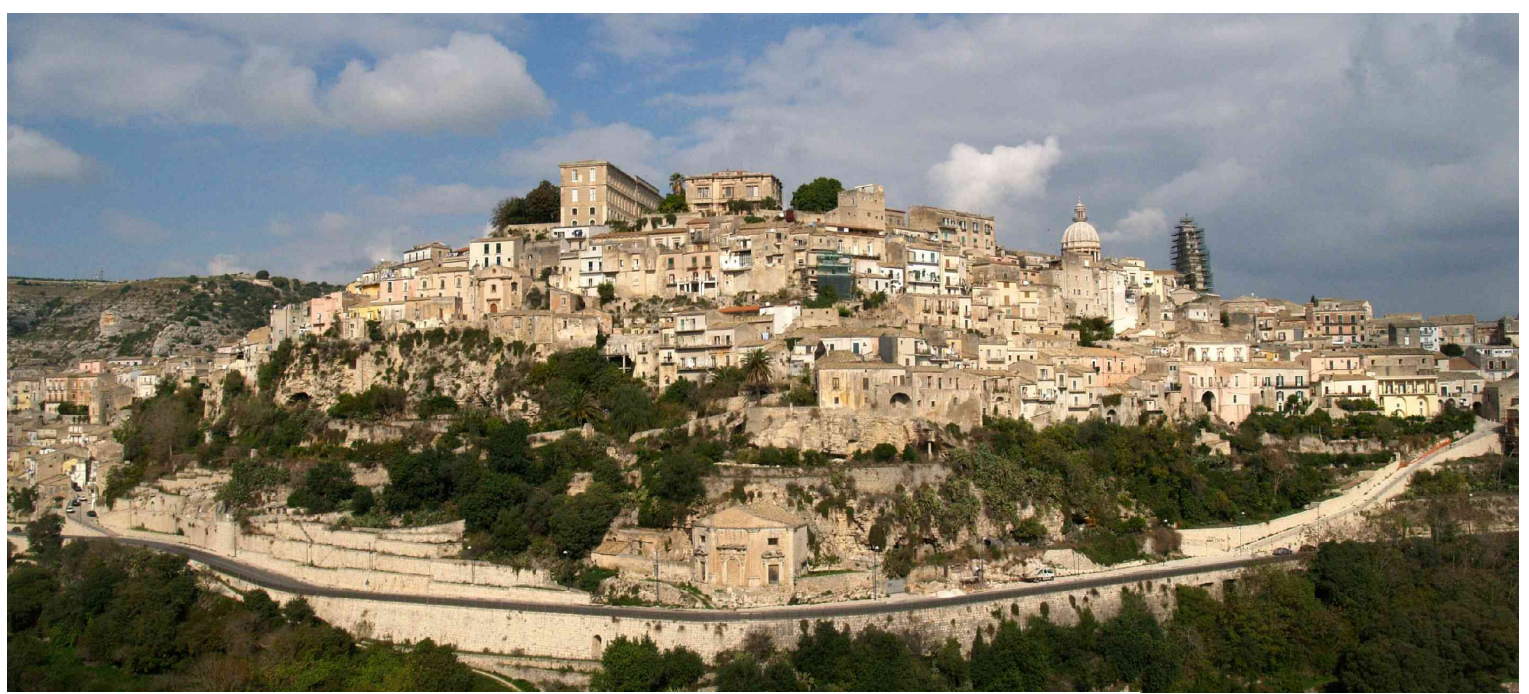
ラゲーサ・イブラ全景。中央右に見えるキューポラは大聖堂のもの。その右手に工事中のファサード。
