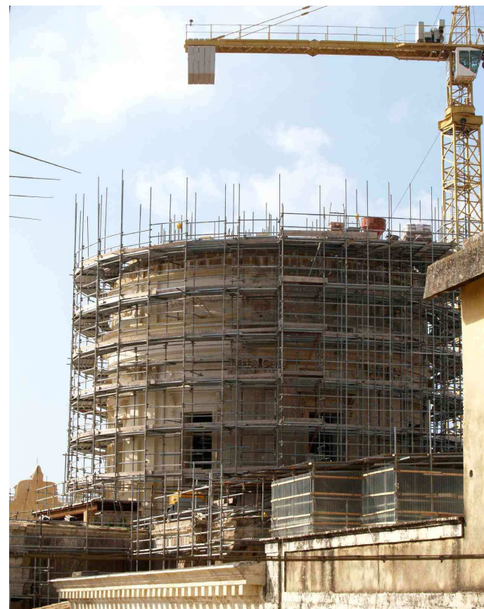
再建工事中の大聖堂キューポラの立ち上がり部分。
