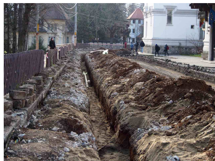
工事中の道路。右手に小さく見えるユーロ旗がホテルの裏口。
