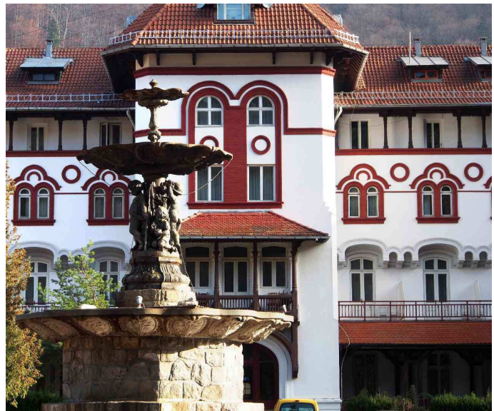
正面から見るホテル カライマン。白壁部分が2、3、4階。泊まったのは3階で噴水のすぐ左側2番目に見える窓の部屋。
