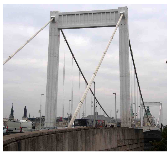
エリザベート橋。
